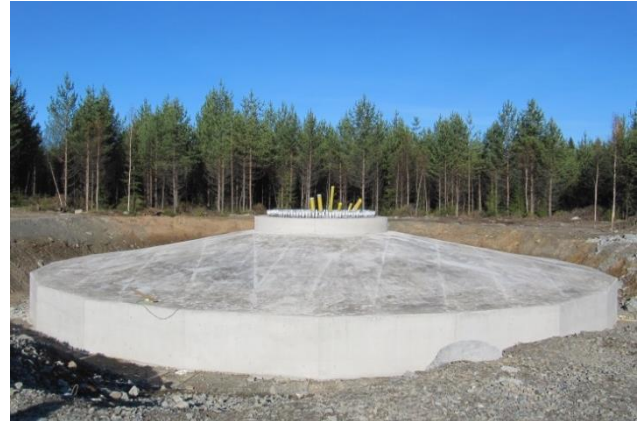
Kuvapari 5-15. Tuulivoimalan perustusten rakentamista (Kuvat: Leila Väyrynen/FCG).
