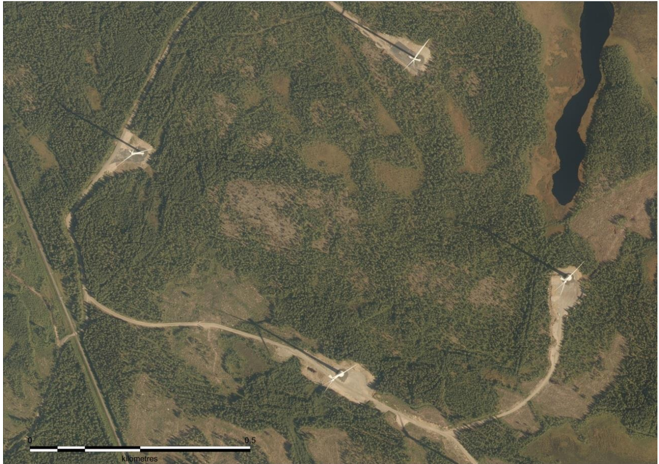
Kuva 5-1. Ilmakuva rakennetusta tuulivoimapuistosta.
