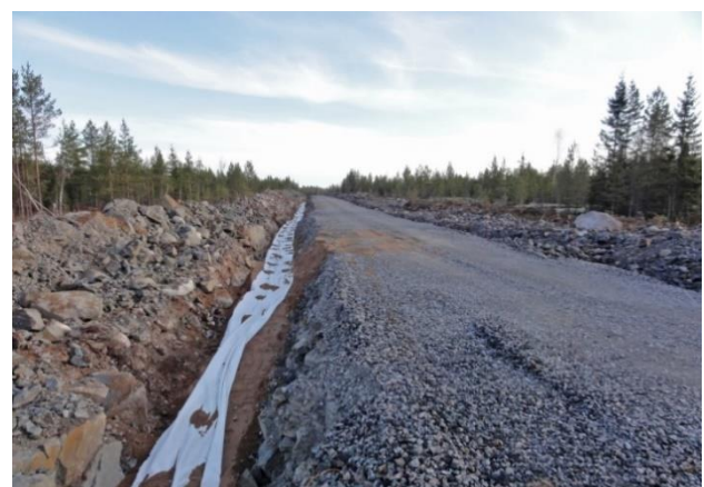
Kuvapari 5-14. Maakaapelit upotetaan huoltoteiden yhteyteen (Kuvat: FCG).
