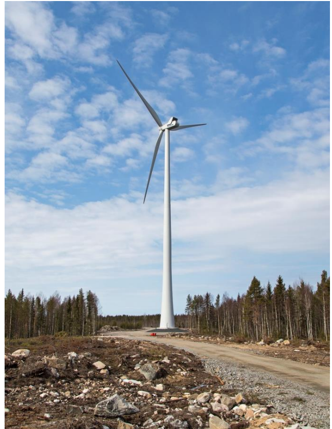
Kuvapari 5-2. Vasemmalla on esimerkki teräslieriötornista ja oikealla hybriditornista (Kuvat: FCG).
