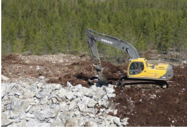
Kuvapari 5-13. Tuulivoimapuiston rakentaminen alkaa huoltoteiden ja pystytysalueiden rakentamisella (Kuvat: FCG).
