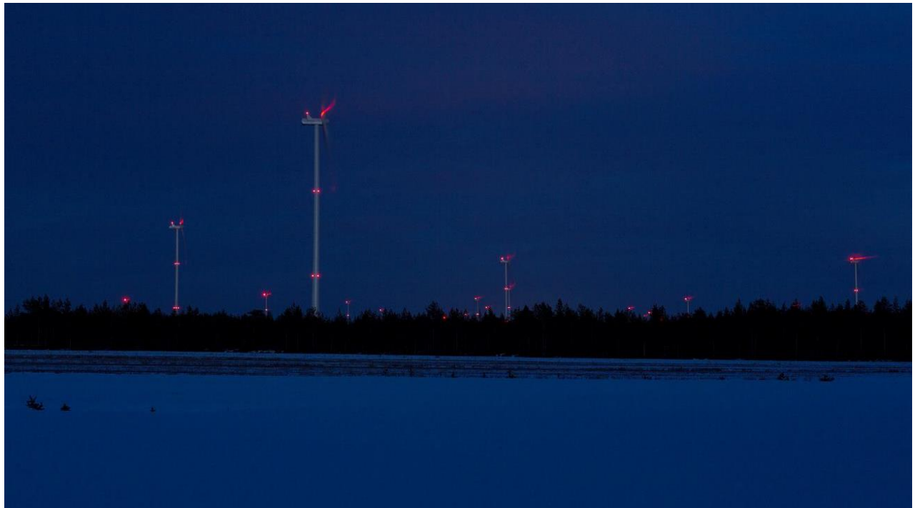
Kuva 5-5. Kiinteät punaiset lentoestevalot (Kuva: FCG).
