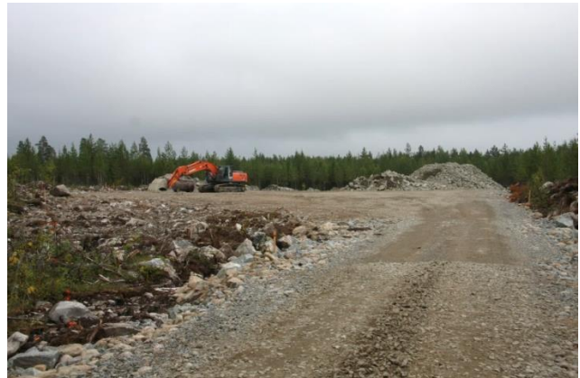
Kuvapari 5-13. Tuulivoimapuiston rakentaminen alkaa huoltoteiden ja pystytysalueiden rakentamisella (Kuvat: FCG).
