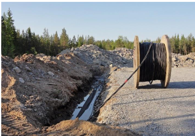
Kuvapari 5-14. Maakaapelit upotetaan huoltoteiden yhteyteen (Kuvat: FCG).
